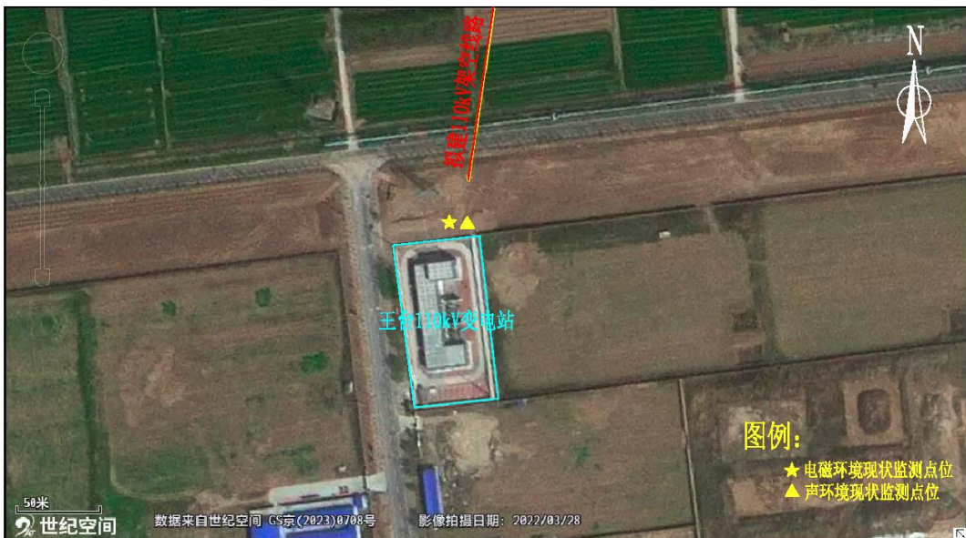
王台 110kV 变电站
