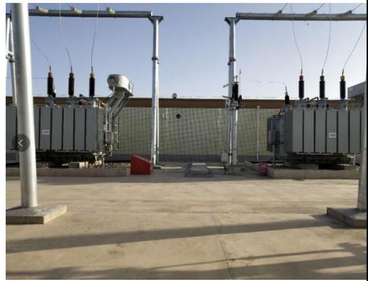
110kV 交城光伏升压站 1#、2#主变和油坑
