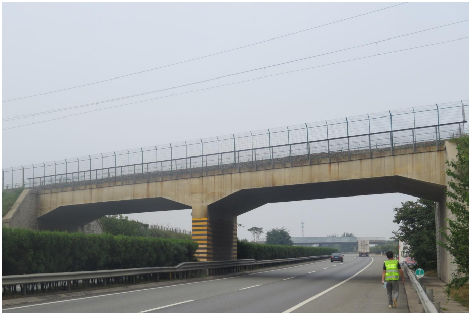
图 13 既有道路下穿侯西铁路框架桥
